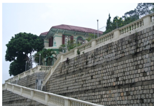
Figura 5.5.8: Vista da Estrada da Vitória para o Edifício.
