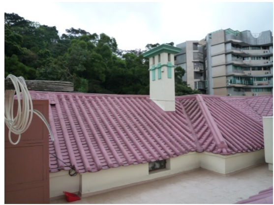
Figura 5.5.4: Pormenor do telhado e chaminé, mantendo o desenho original
